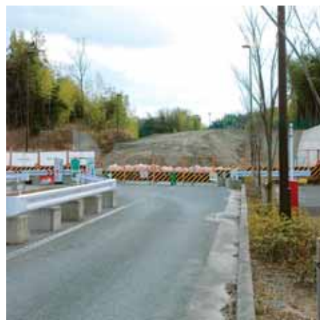
工事が進む山手幹線(同社社山手地内)
