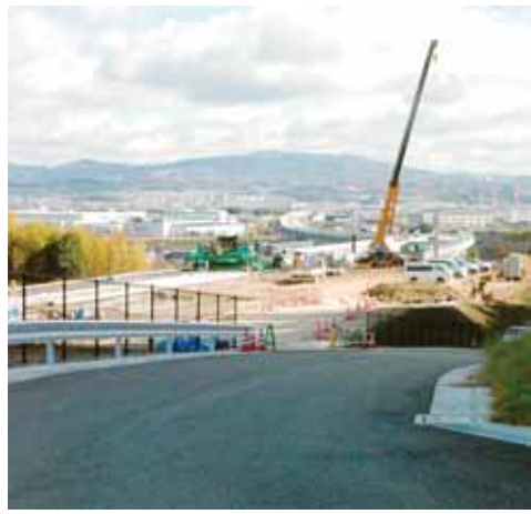
建設中の新名神高速道路と市道今池西ノ垣内線
