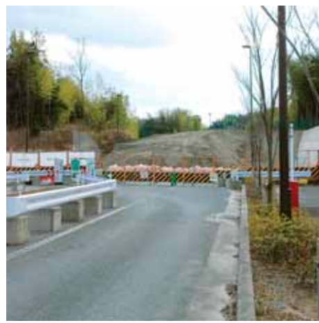
工事が進む山手幹線(同社山手地内)
