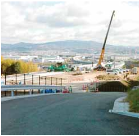
建設中の新名神高速道路と市道今池西ノ垣内線
