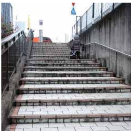
JR松井山手駅東側と松井ヶ丘三丁目を結ぶ階段
