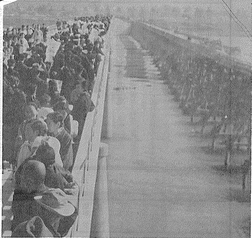
木津川玉水橋架けかえ工事竣工(昭和31.11)
