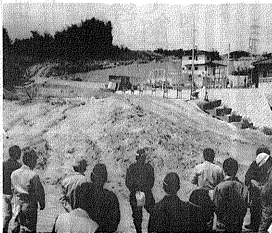
宅地造成地の危険箇所をチェック
