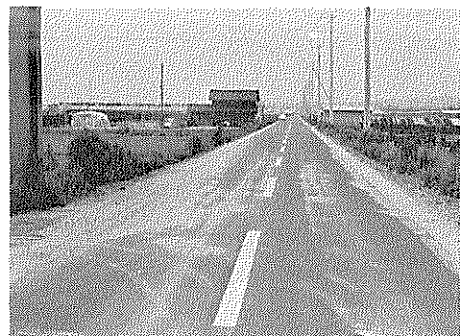
農免道路、草内一山本線も半分が完全舗装
