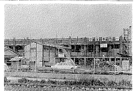
大住小学校は、京阪東ネオポリスの完成にともなう児童の急増に備えるもので、いま工費四千九百五十万円、鉄筋コンクリート二階建ての六教室を新築しています。
