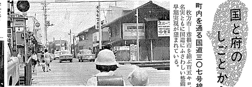
沿線待望の国道307号線の新田辺駅の拡巾と歩道もできる
