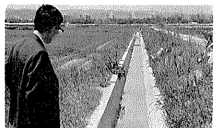
かんがい排水路完成(東区で)
