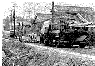
ことしも部落内の道路を舗装(田辺・観音岡地)
