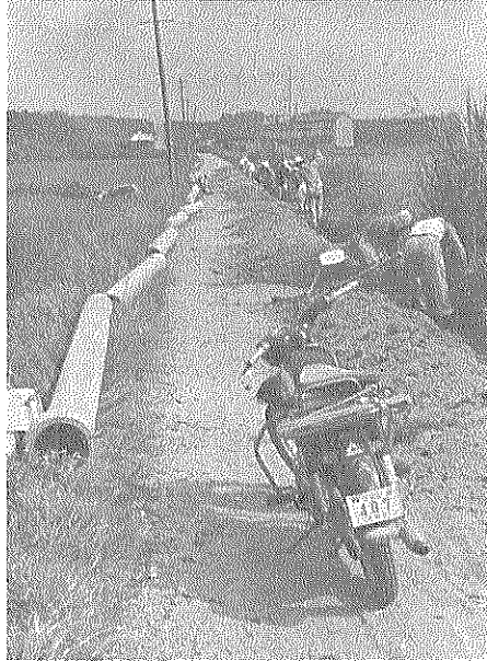
送水管敷設工事
