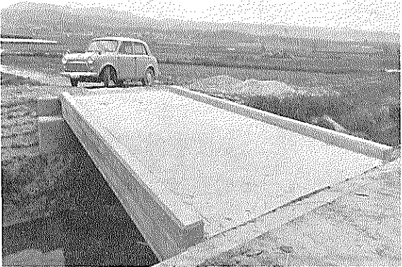
勇田橋 (田辺区) 橋長9メートル 巾員3メートル 橋台2基、橋体プレストレス桁橋
