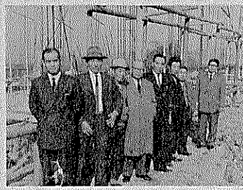
現場を視察する町議会建設委員
