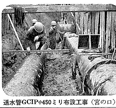
送水管GCIPφ450ミリ布設工事(宮の口)
