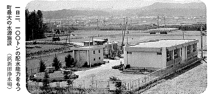
一日三、一〇〇トンの配水能力をもつ町最大の水源施設(浜新田浄水場)
