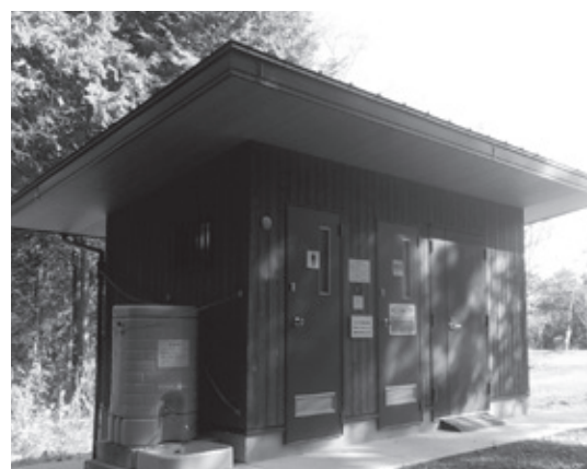
新設された甘南備山パイオトイレ
