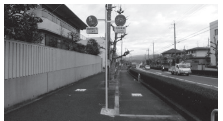
自転車道規制標識の整備
