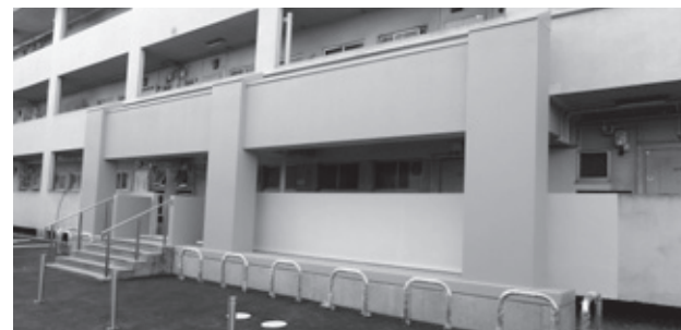
市営住宅南山団地の耐震補強工事が完成
