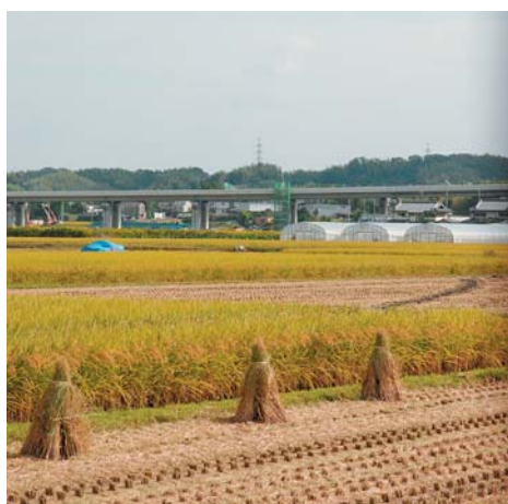
松井地域から見る建設中の新名神高速道路
