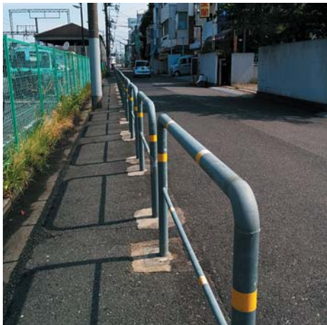
車いすも通れない歩道 (近鉄新田辺駅東側)
