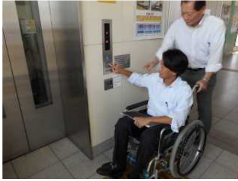
【 目線の高さにボタンがある （新田辺駅東口エレベータ） 】
