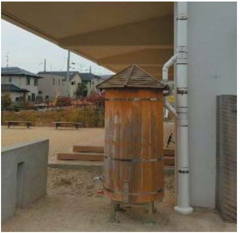
同志社山手北公民館の雨水タンク
