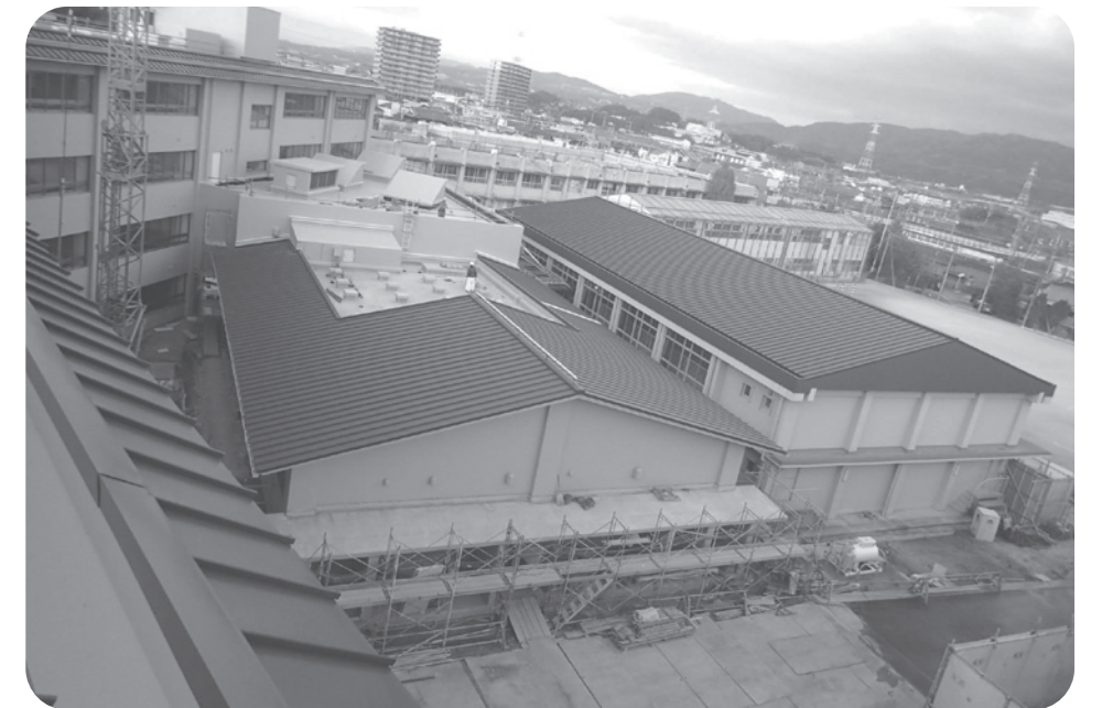
着々と建設が進む三山木小学校西校舎棟、給食室棟工事
