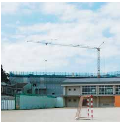
体育館の西側で建設が進む西校舎棟(三山木小学校)
