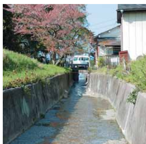
水路橋の手前で幅が狭くなっている天津神川
