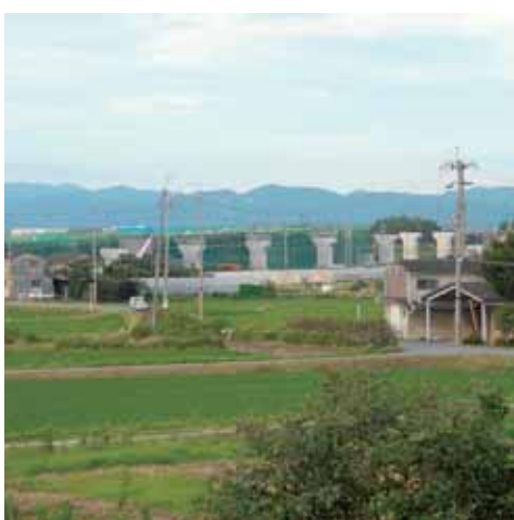
工事が進む新名神高速道路と その付近の大住工業専用地域
