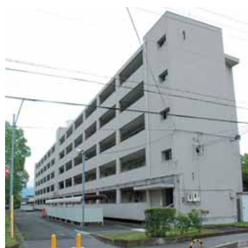
戸数条件によりエレベーターが設置できない棟(田辺団地)
