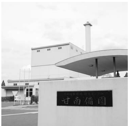
本市のごみ焼却施設である甘南備園
