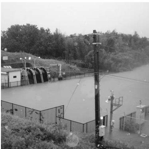
台風18号接近時の神矢樋門排水ポンプ場(平成25年)
