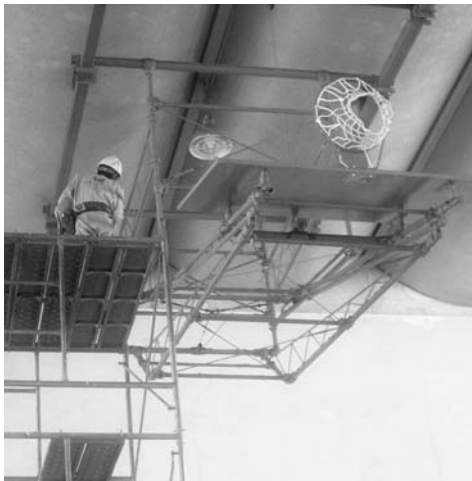
耐震改修の必要性を調査する非構造部材の点検(市内中学校)
