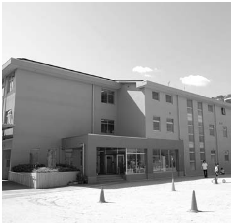
耐震改修工事が完了した田辺中学校
