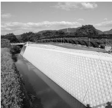
台風による被害のため復旧工事をした擁壁（井路川樋門排水路）
