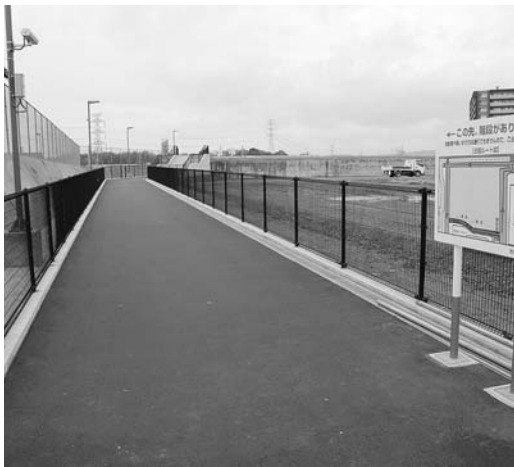
第二京阪道路の上を横断するように新設された市道
