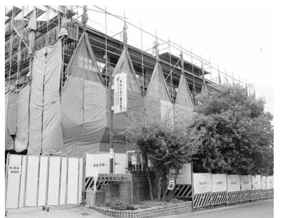
改修工事が進む社会福祉センター
