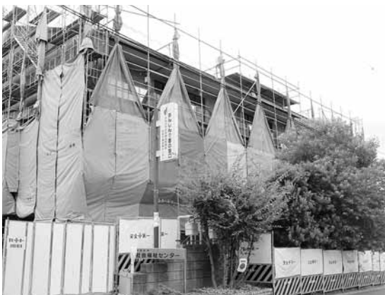
改修工事が進む社会福祉センター
