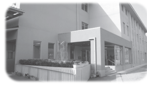
田辺中学校新管理棟
