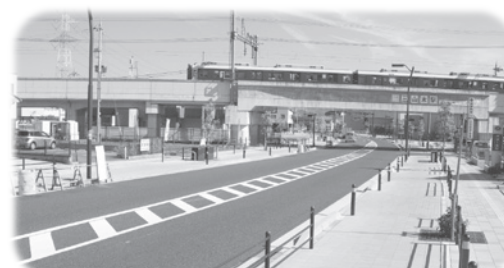
三山木普賢寺線自転車道整備
