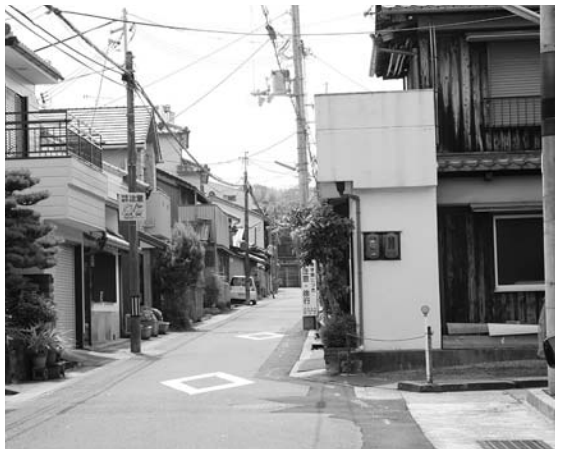
整備が必要な通学路(田辺地内)
