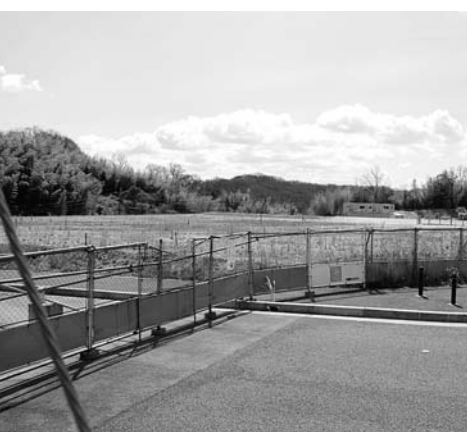
特別養護老人ホーム建設予定地(同志社山手地区)
