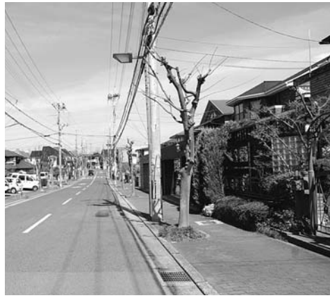
安全対策が求められる花住坂公民館前道路
