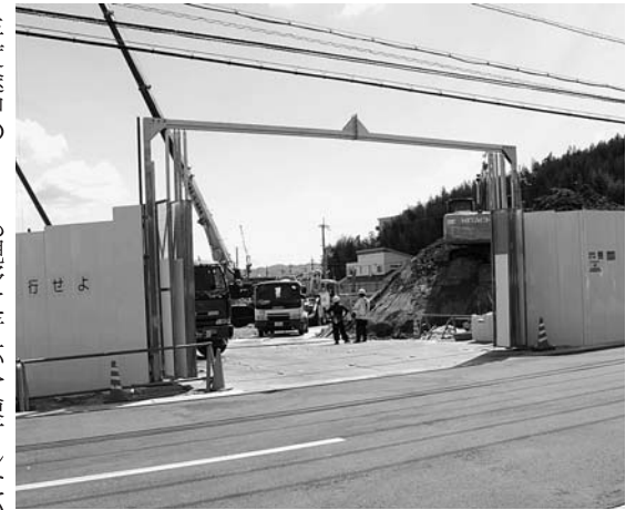
三山木保育所の建設が始まった工事現場
