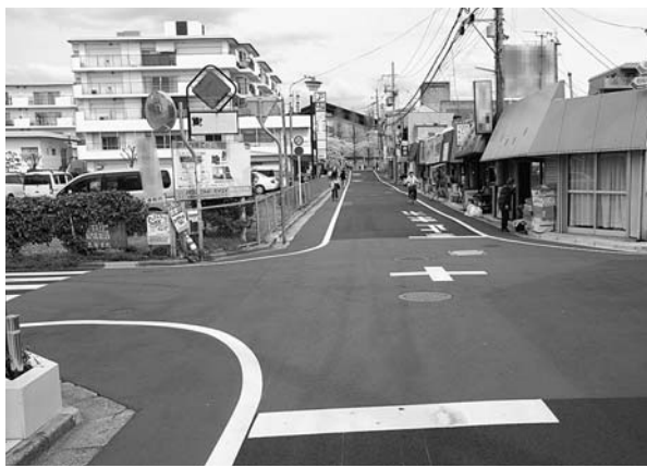
カラー塗装された道路 (新田辺駅東側商店街～馬坂川)
