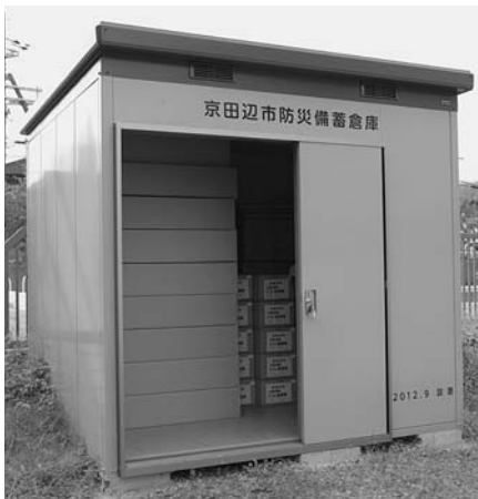
学校敷地内に設置された防災備蓄倉庫
