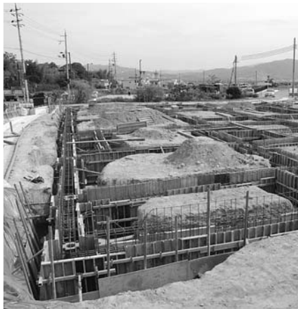
移転工事が進むみみづく保育園
