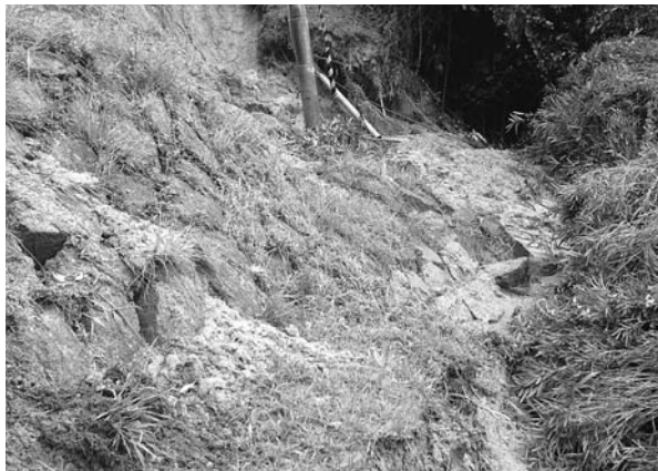
台風18号による豪雨で被害を受けた土地
