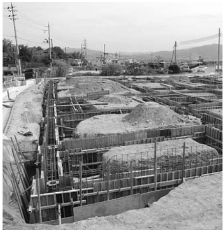
移転工事が進むみみづく保育園
