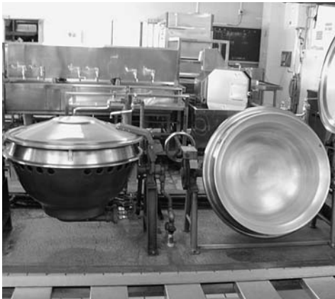
市内小学校の給食室
