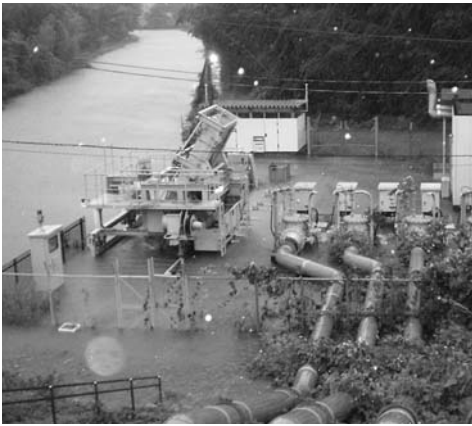
台風18号の豪雨により 浸水した神矢樋門の様子
