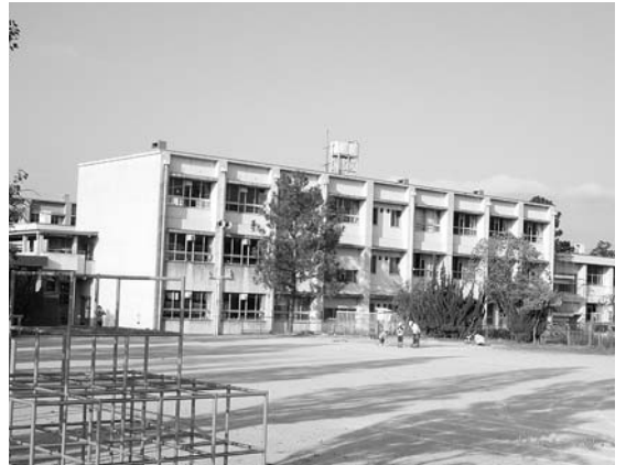
空調設備の設置が待たれる 市内の小学校
