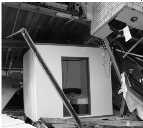
倒壊家屋の中で 持ちこたえる耐震シェルター
