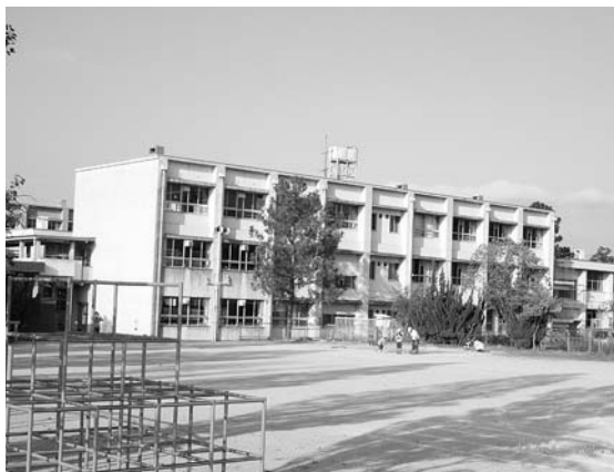
空調設備の設置が待たれる 市内の小学校
