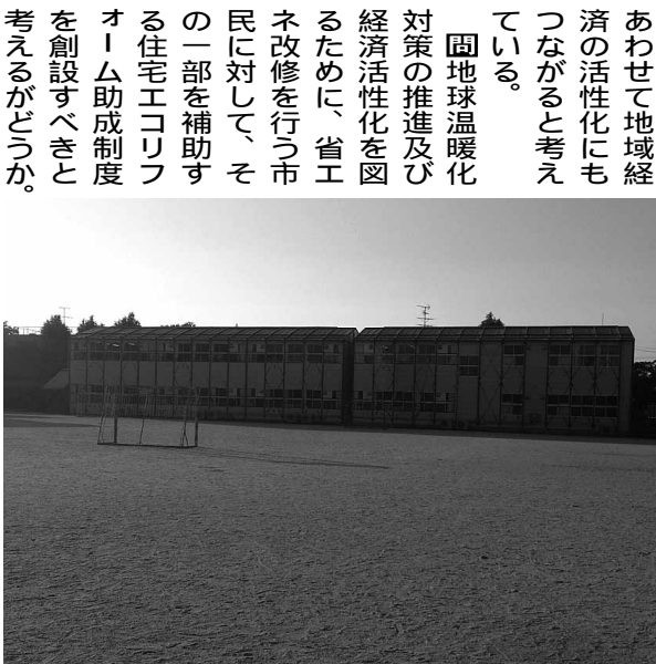
空き教室を利用する三山木小学校の学童保育(仮設校舎)
