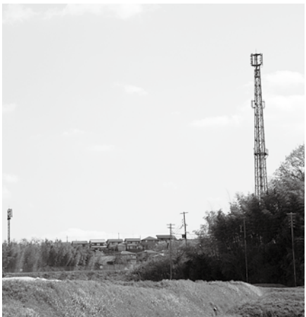
携帯電話中継基地局がならぶ地域
