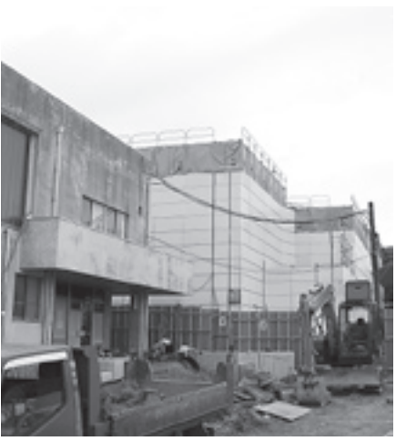
新築等の工事が進められている田辺中学校
