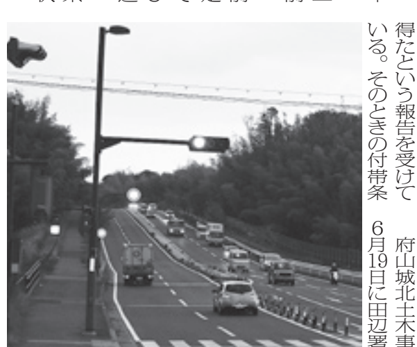
歩道用照明が未設置の山手幹線(興戸地蔵谷橋付近から北方向を望む)
