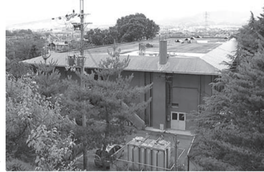
財源確保として太陽光発電のため、企業に公共施設の屋根の利用を提案(中央公民館)
