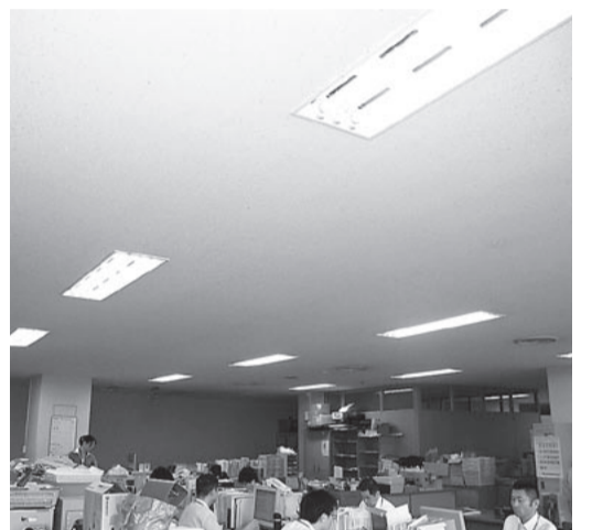
蛍光灯1本をはずし節電に取り組む市役所内事務室
