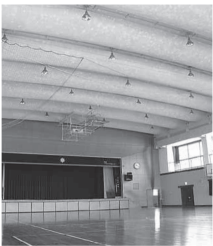
耐震改修が行われる培良中学校屋内体育館
