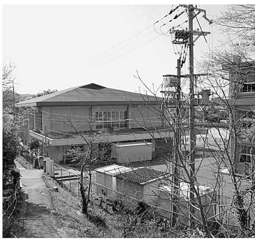
24年度中に屋根の全面改修が行われる田辺小学校体育館
