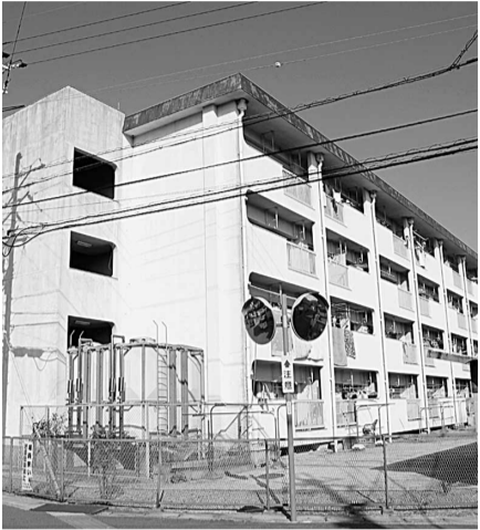
耐震補強工事が行われる谷ノ上団地
