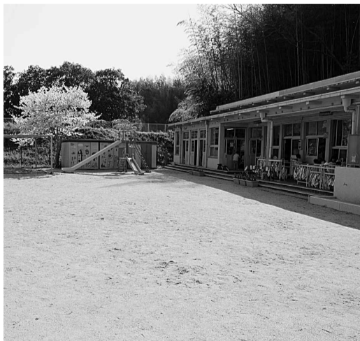
園庭に仮設園舎が建設される三山木保育所
