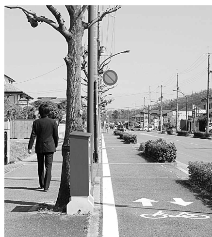
歩道に自転車レーンが整備された道路 (山手幹線松井ヶ丘地区)
