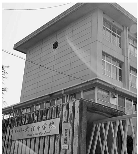
空調設備設置工事が行われる 大住中学校
