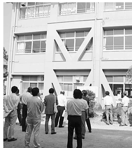
耐震補強工事が行われた大住小学校の校舎
