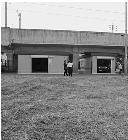
地域の防災を担うために新設された南部水防倉庫
