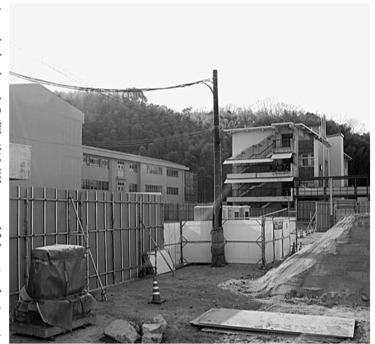
校舎の新築工事等が行われている 田辺中学校
