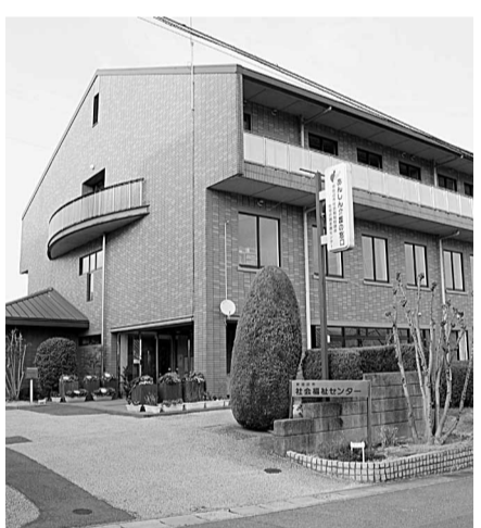
改修のため調査が行われる社会福祉センター
