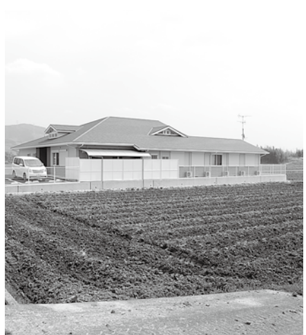
完成した「草内ホーム」
