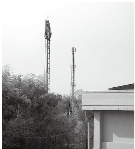
市内各所に設置されている携帯電話電波塔
