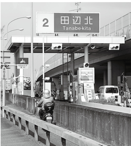
100円橋区間はバイク、自転車も通行できる道路
